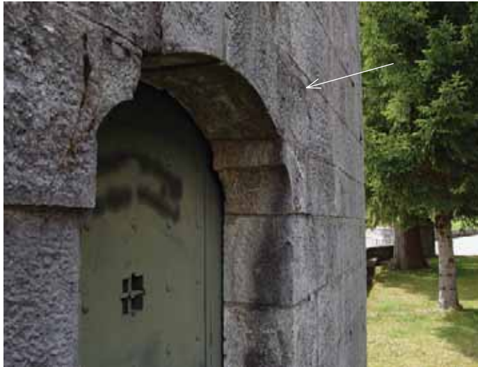
la freccia indica il punto, ancora visibile, in cui è entrato il fulmine
