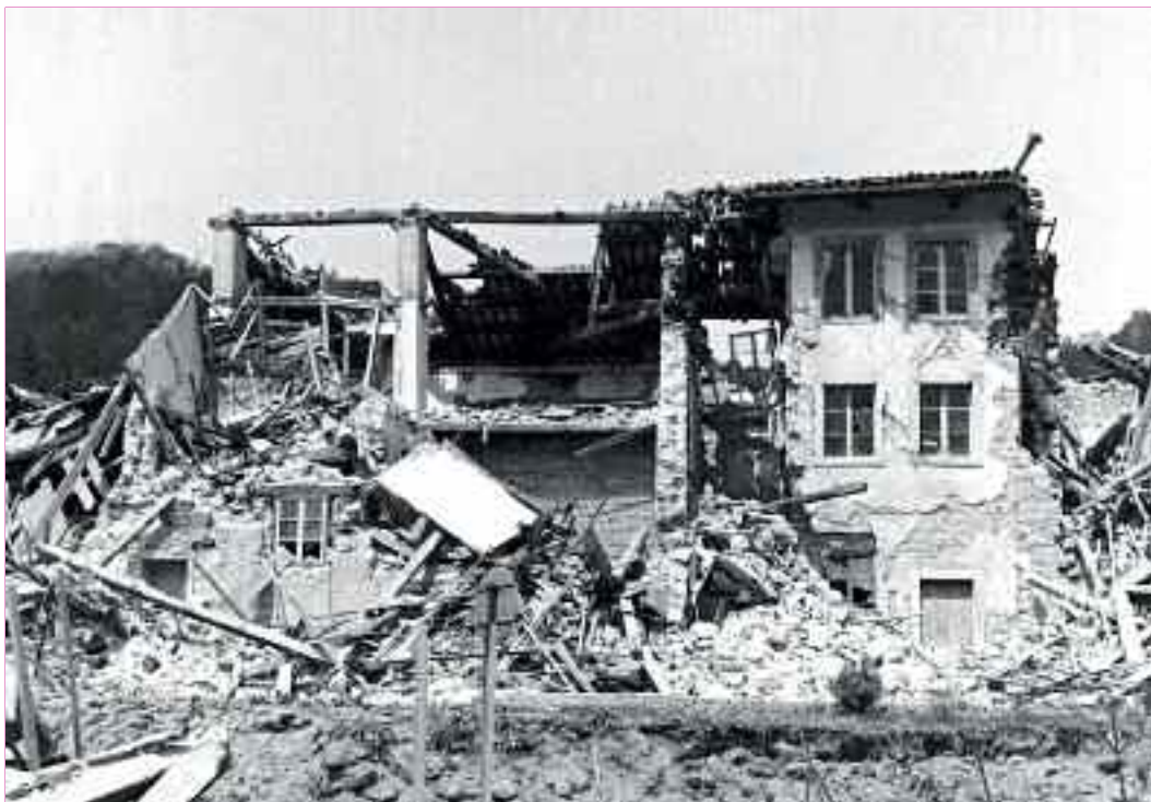
L'edificio della canonica, a sinistra ed il municipio, comprensivo della scuola elementare, devastati dall'onda sismica
